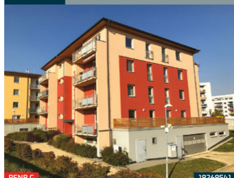
BYT 2+kk ŠLAPANICE / Brněnská Pole
